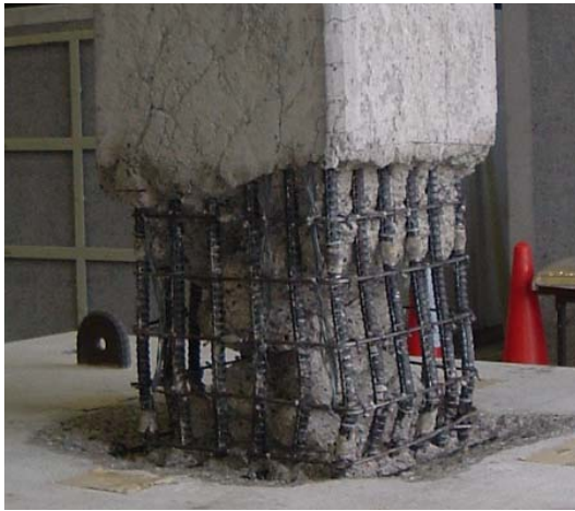
(a) 損傷部除去
