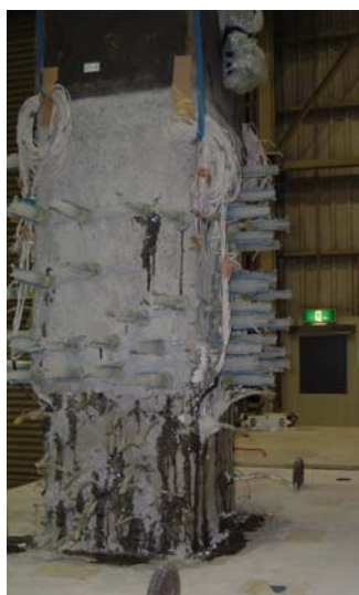
(c) エポキシ樹脂注入
