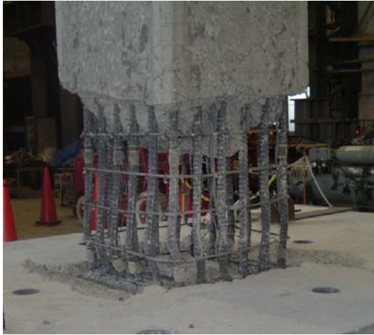
(a) 損傷部除去
