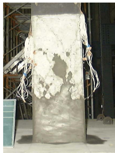
(d) 補修完了
