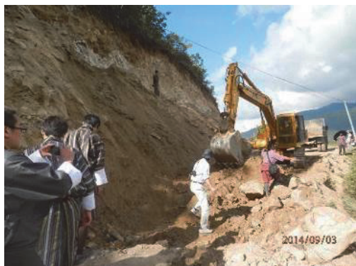
写真3 工事中の道路
