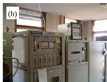
図 1 排水水質自動監視システム (Anatec Yanaco)
