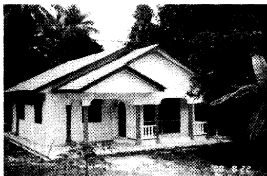
写真4 新しいブロックを用いた家
