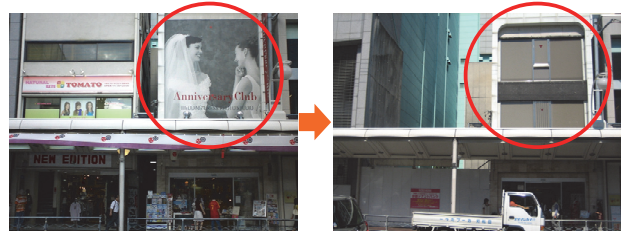
写真-3 固定型屋外広告物の撤去
