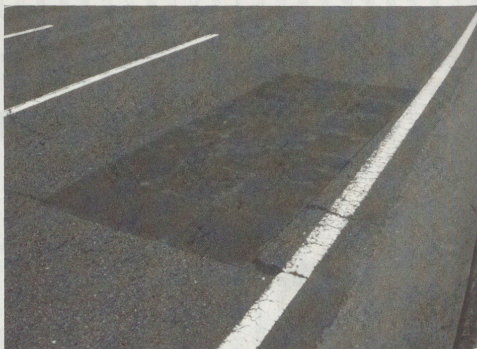
写真6 施工2年後の状況
