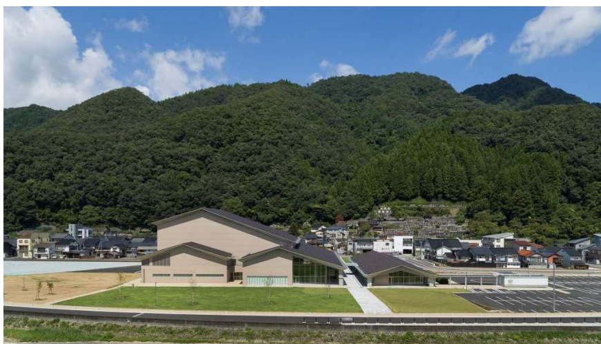
写真 4-2 八木川から南側外観を見る
