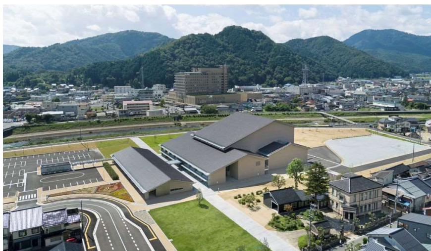
写真 4-3 敷地北東上空から北側外観を見る
