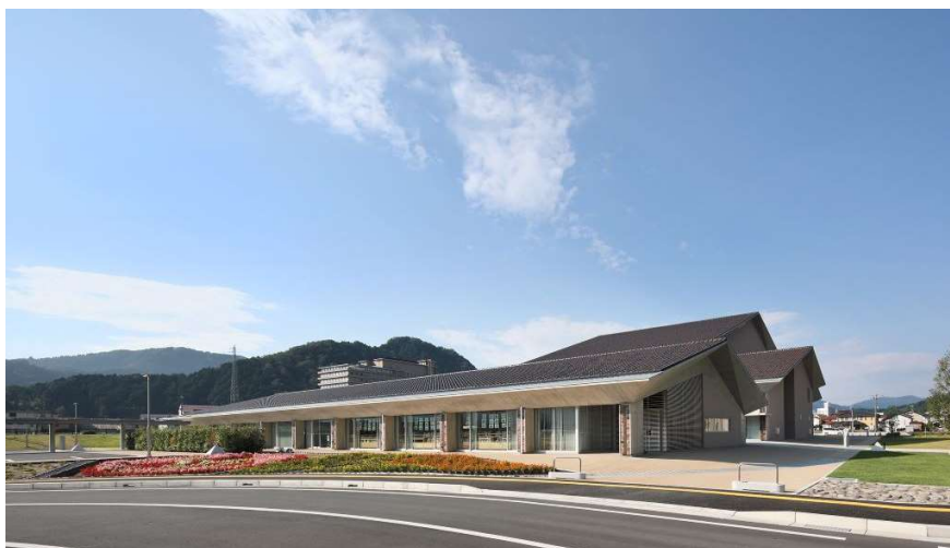
写真 4-4 新市道から東側外観を見る
