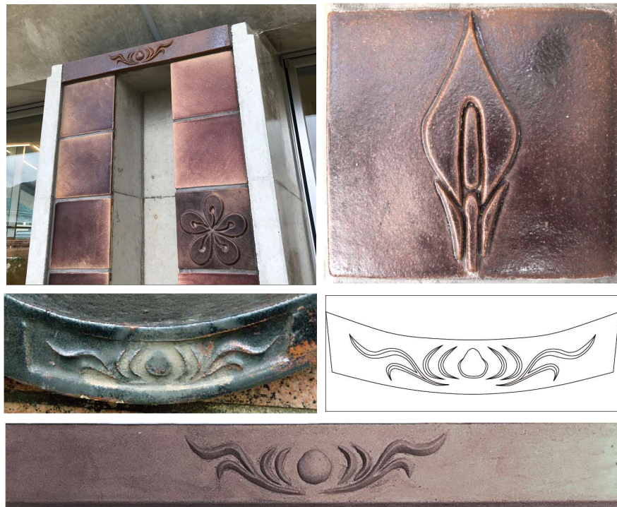
図 6-2 壁瓦の詳細（上左：完成状況、上右：市花模様があしらわれた壁瓦、中左：保存されていた八鹿瓦の瓦当模様、中右：瓦当模様のグラフィック処理、下：瓦当模様があしらわれた壁瓦）
