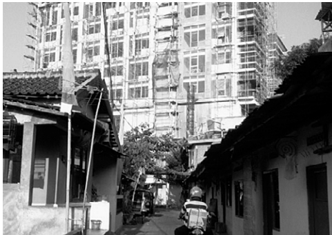
写真2 チョデ川付近に建設中のホテル
