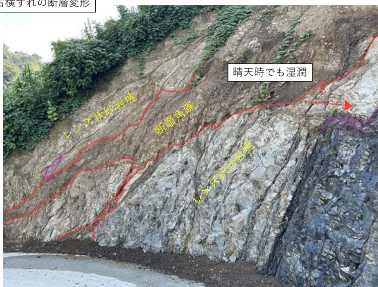
流動性崩壊は断層角礫への浸透と崩壊が原因・断層角礫は風化とも関係
