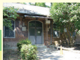
リニューアル前の赤煉瓦倉庫(平成23年撮影)。昭和25~36年は教養部の講義棟として、昭和40年代に化研が宇治に移転してからは窯業化学実験工場として使用されていた。
