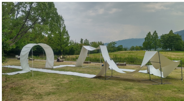
塩ビ管とジョイントによって構成された折りたたみテント
