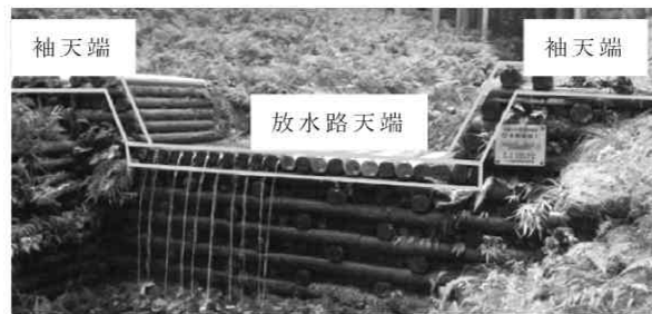
写真7： 木製治山ダム
