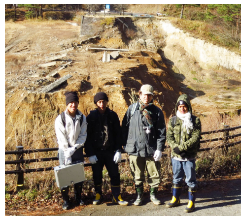
写真-2 サンドウィッチプログラム学生と 行った福島県須賀川市の藤沼ダム 崩壊現場の調査
