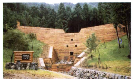
丹波の森公苑内の砂防堰堤。コンクリート表面を木製パネルで覆い、周囲の森景観と調和させようとしている。
