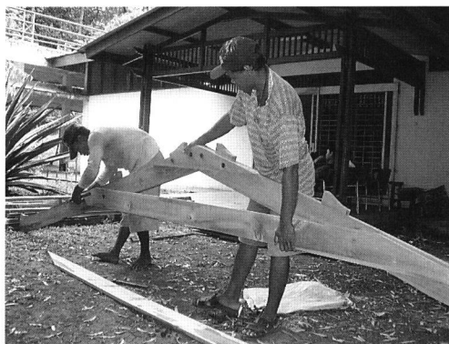
b) 骨組み架構の製造と建ち上げ
