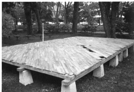
a) コンクリート製独立基礎と床構面の施工
