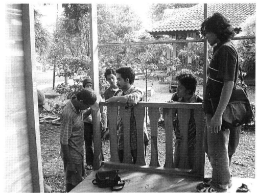
e) プレファブ耐力壁ユニットの組み込みとバルコニーの設置
