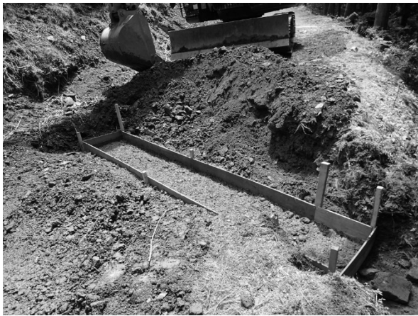
写真 1 床堀～基礎用型枠設置（工程 2,3）
