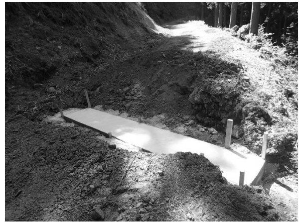
写真 2 生コン打設（工程 4）
