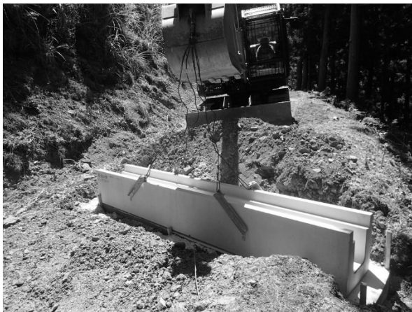
写真 3 ロング U 設置（工程 5）
