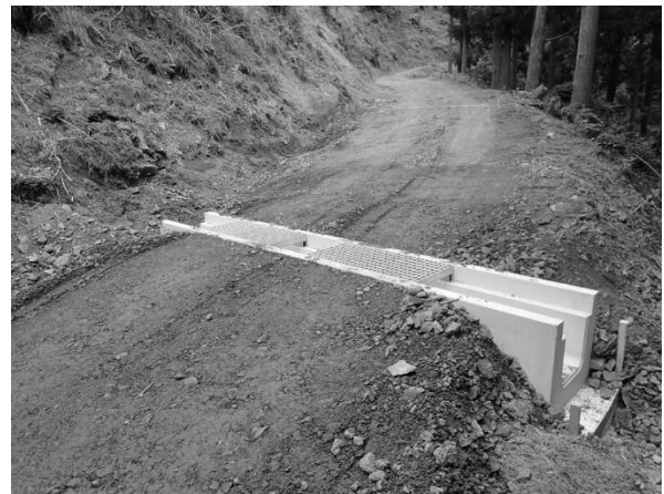
写真 4 埋戻し（工程 5）
