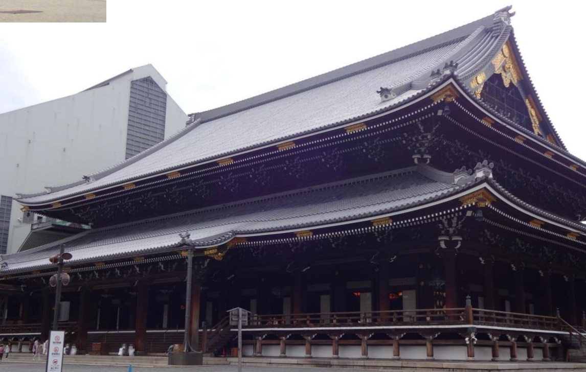
世界最大の木造軸組建造物 東本願寺御影堂 出典：筆者撮影
