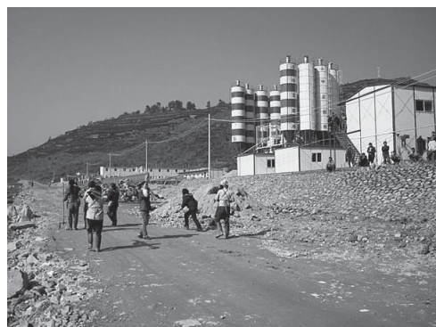
写真1 鉄道部の事務所と農民工の宿舎
