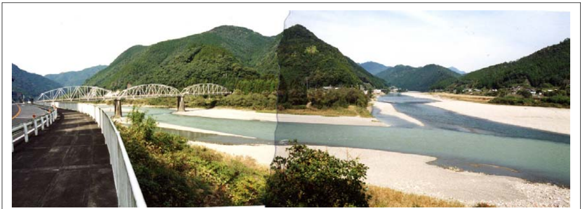
写真2 十津川（左）と北山川の合流点付近の様子。十津川の水は白濁している，原因は砂利採取。北山川は澄んでいる。砂州の礫径は北山川からのもののほうが大きい。北山川流域の石のほうが堅くて破碎し難い。2000年11月13日撮影
