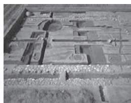
本薬師寺中門（下層に西三坊坊間路と東西両側溝を検出。南から見る）
