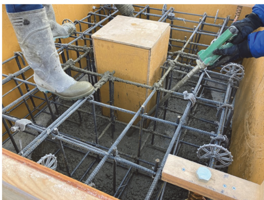
⑨ コンクリート打設
