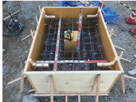
⑧ 型枠・配筋
