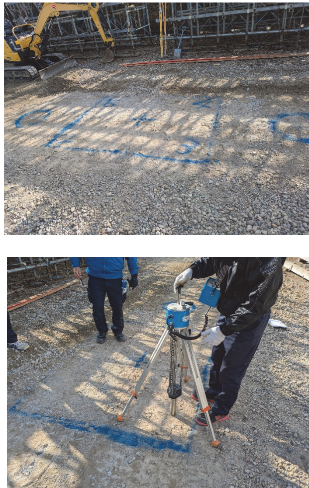
図 3-3 キャスポル試験（上図：対象地盤、下図：試験状況）
