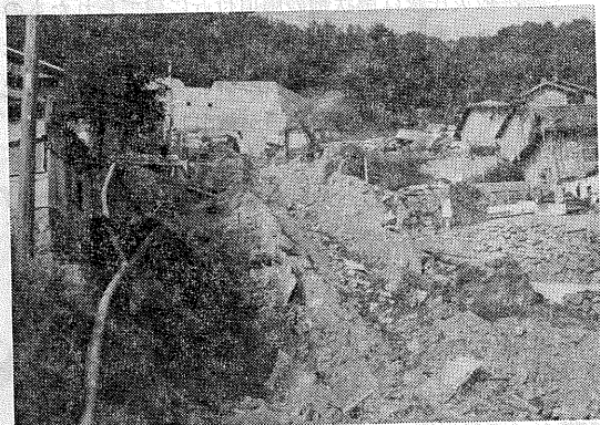
第7図 内間川の倒壊家屋跡地と災害後造られた内間川堰堤（高さ8m、長さ50.5m）
