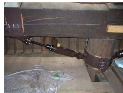
小屋裏の柱－梁接合部
