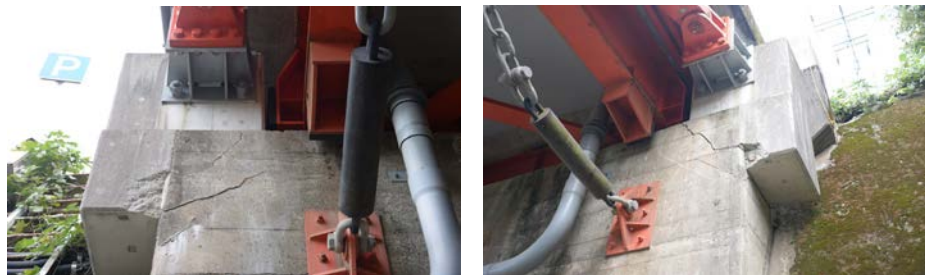
(iii) A2 橋台 (西側)
