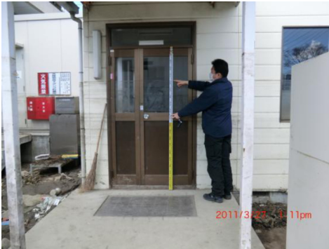
写真-2 国土交通省塩釜港湾・空港事務所の浸水跡
