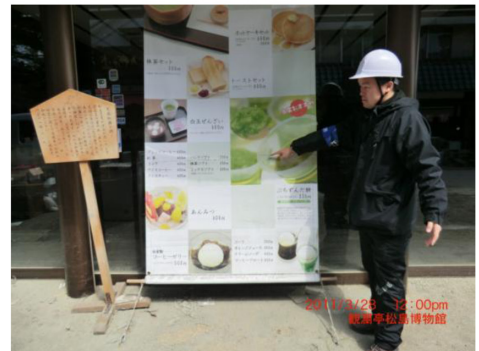
(2) 松島町瑞巖寺前の土産物店（泥跡） 写真-1 津波痕跡の調査と整理法
