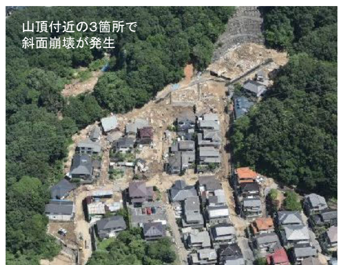
(c) 広島安芸区矢野東で発生した土砂災害 (平成30年7月西日本豪雨) 9)
