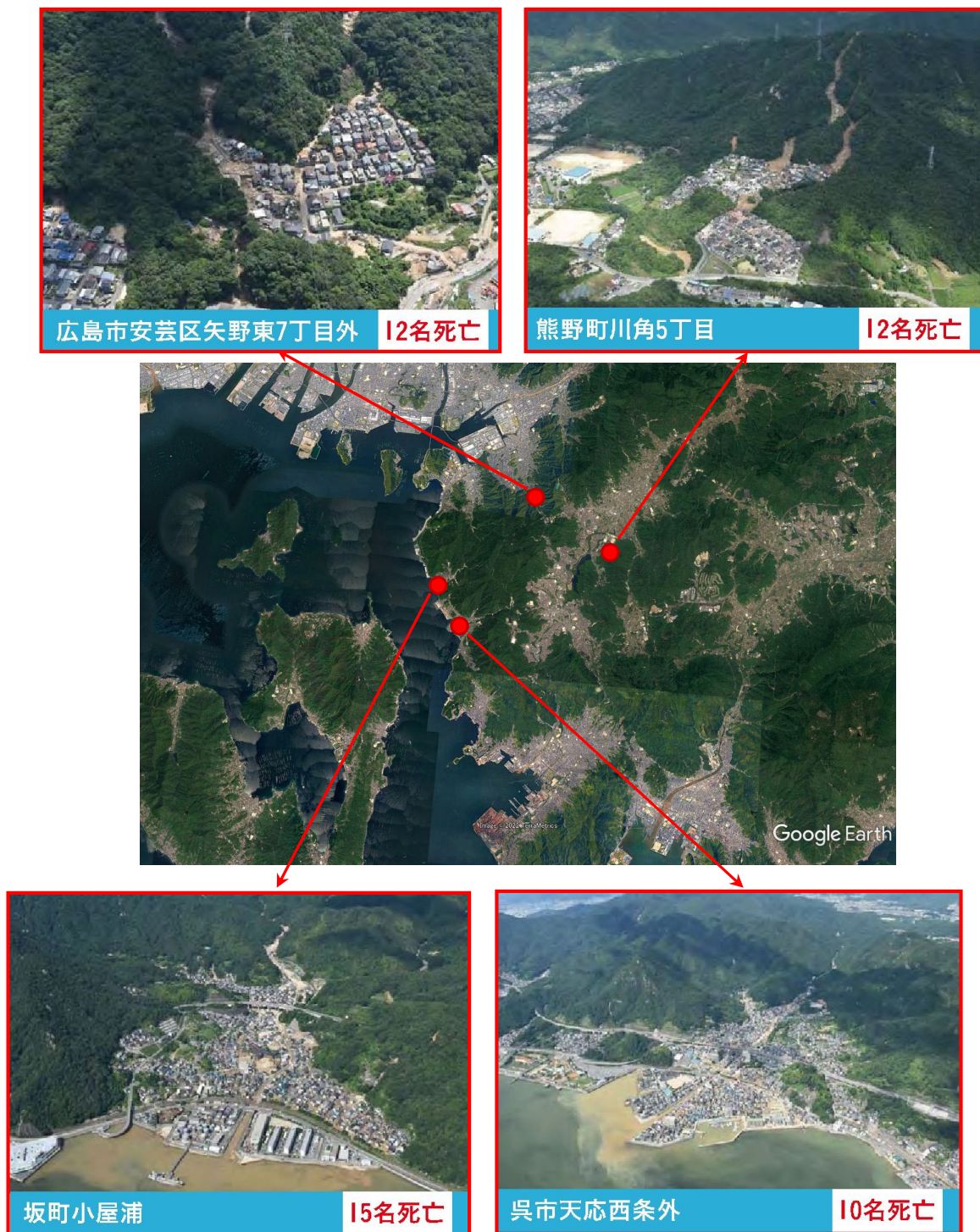
図 4.3.3 平成 30 年西日本豪雨による広島県内の被災状況 4)
