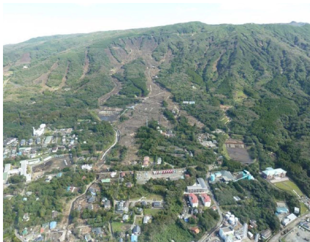
(a) 平成 25 年台風 26 号による土砂災害 (伊豆大島) 2)
