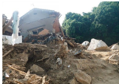
(f) 土石流による家屋被害
