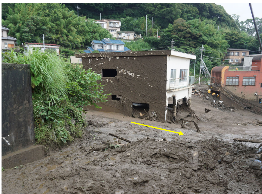
図 3.3.4 泥流により被災した家屋（令和3年7月 静岡県熱海市伊豆山）
