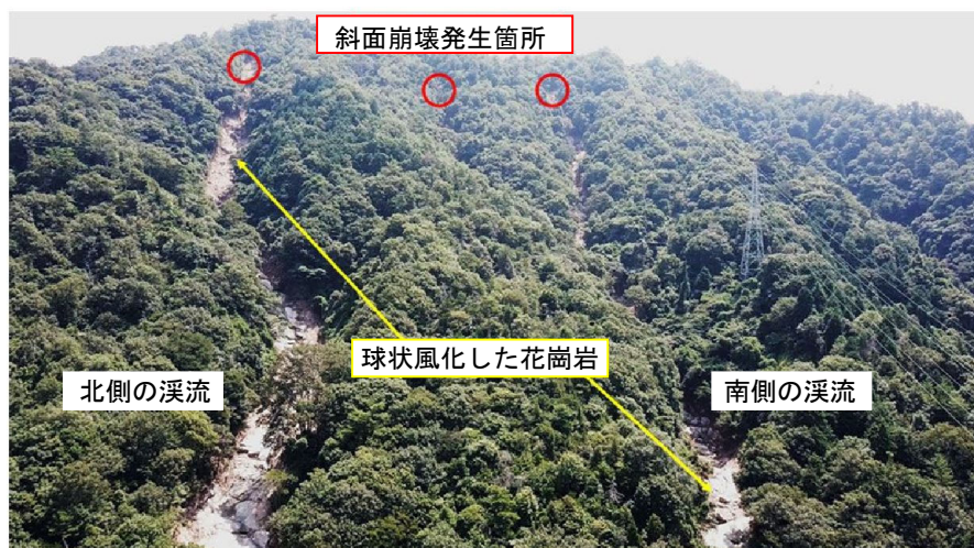
図 4.3.5 梅河団地北側 13 溪流の被災後の様子 5)
