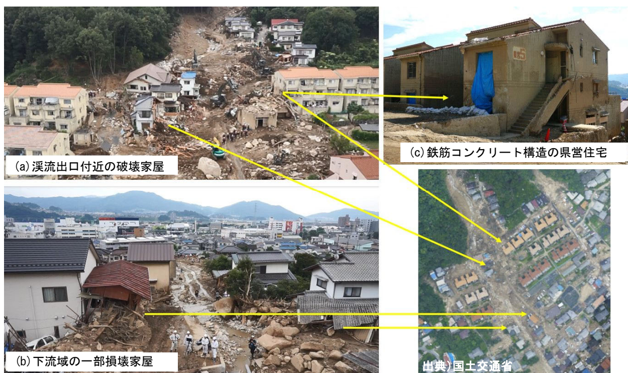
図 4.2.6 広島市安佐南区八木三丁目における家屋の破壊状況
