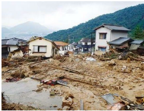
(a) 土石流の流れによる被害
