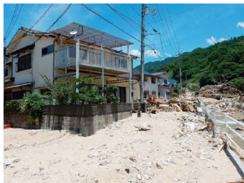
(g) 土砂堆積による被害
