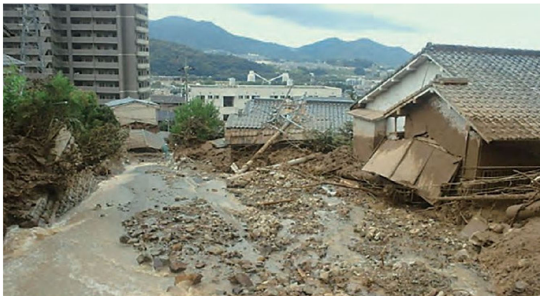
図 4.2.4 広島市安佐南区八木三丁目付近の被災状況 1)
