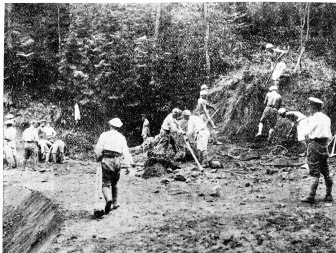
花山道路作業中の伏見工兵隊
