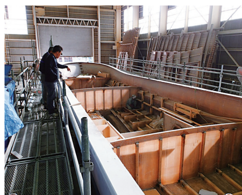
写真3：新「緑洋丸」の外殻補強作業
