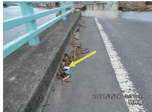
写真7 橋の先端部に残る木切れ・漂流物痕跡
