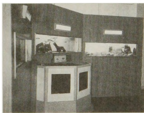
写真11 水槽前面に化粧合板で間仕切り。
