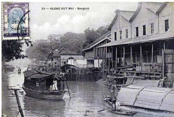
Padung Krungkasem Canal
