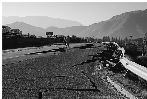
写真 7 国道 5 号線に隣接する一般道の盛土天端の被災状況
