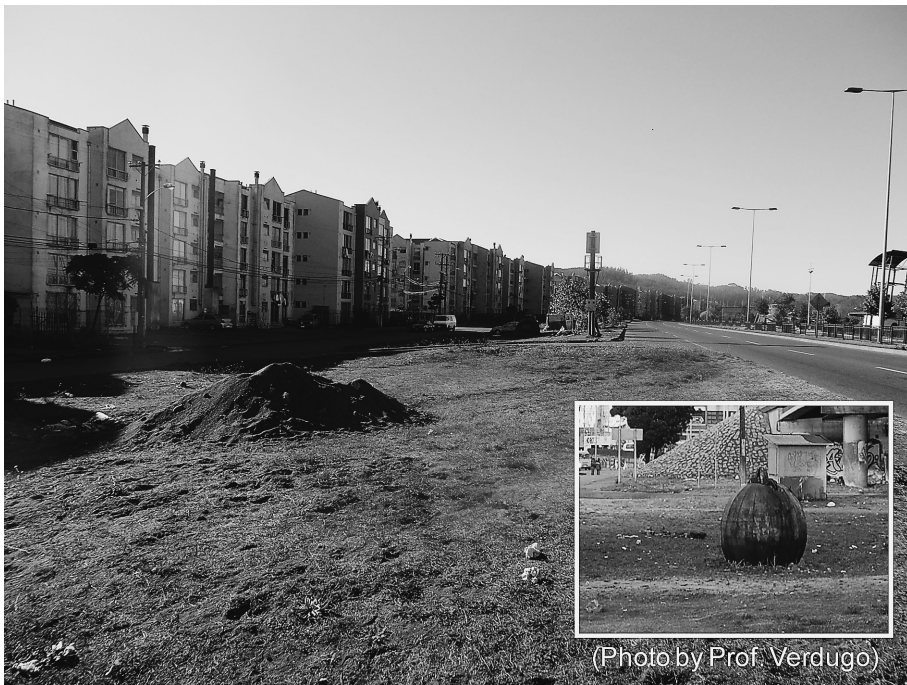
写真17 動圧密工法による地盤改良でほぼ無被害であったアパート群（リベラ・ノルテ）
