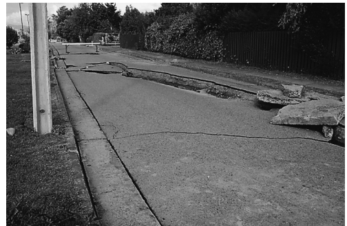
写真14 地盤変状によるアスファルト舗装の亀裂（アラウコ）
