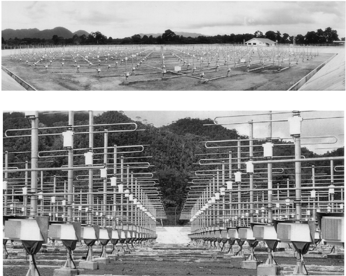
図1 (上) インドネシア西スマトラ州コタバランに建設された赤道大気レーダー (Equatorial Atmosphere Radar; EAR) の全景。(下) 赤道大気レーダーの560本の八木アンテナ群。各アンテナの下部に送受信モジュール (箱状) が設置されている。
