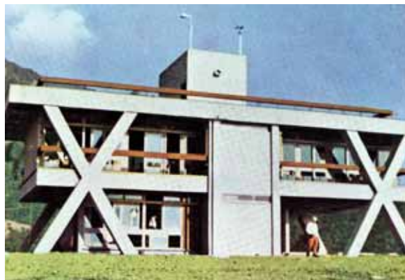
写真 2 ハルタ山観測所
