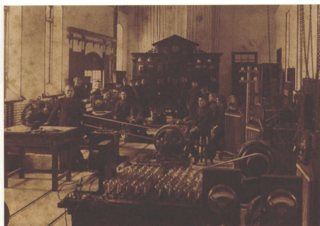
創設当時の電気工學教室実験室
