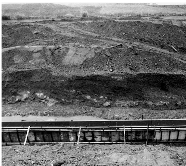
2 河床内堆積状況（その1）
