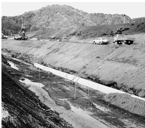
1 調査地付近全景（南東から）
