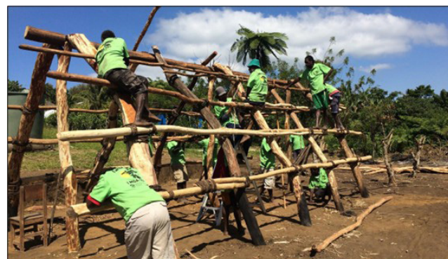
図3 高度化ニマラタンの建設現場
