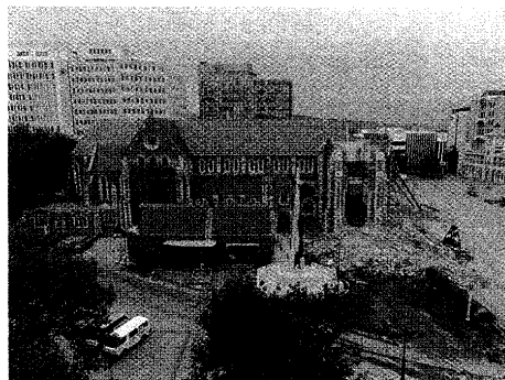
図1——市のシンボルである大聖堂も組積造であるが、尖塔部分が崩壊した[撮影:真田靖士]
