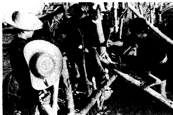
写真6 ノーン・ゲの堤防修理、ナーイ・ケーン(右端)が杭を縛る
