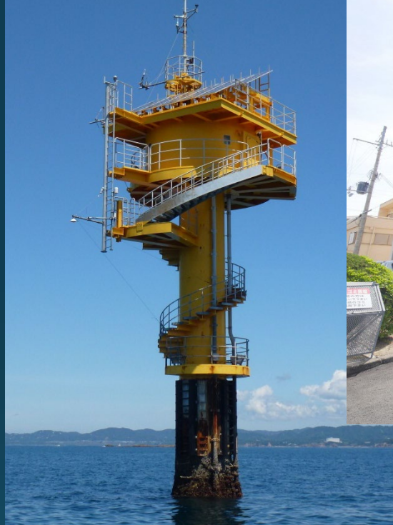
田辺中島高潮観測塔
