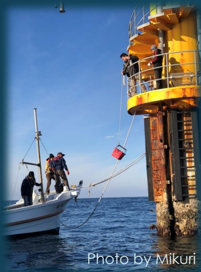
観測塔への計測機器設置作業
