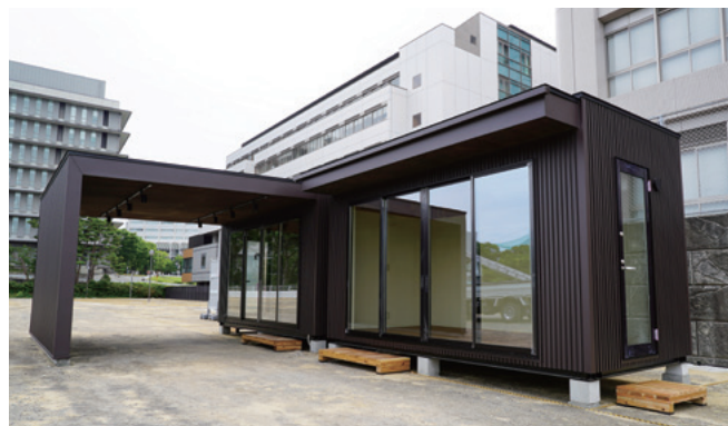
CLT ユニットによる仮設検査場
