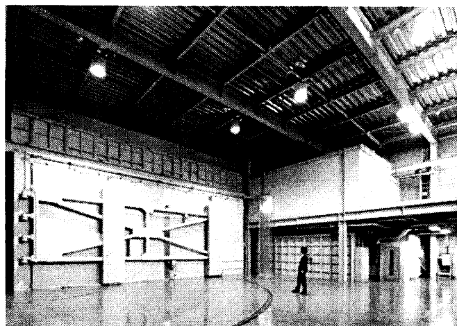
(c) 前室 (電動シールド大扉)
