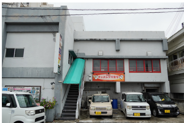
石垣市美崎町に建つ1階が半地下の2階建てRCビル。梁せいが1mを超す強靱さ。かつてはダンスホールとして使われたというが、今は飲食店が入る。実はYさんが所有している。
