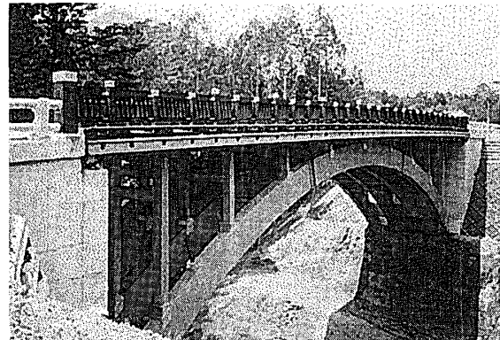
図11 すぎの木橋（宮崎県小林市）
