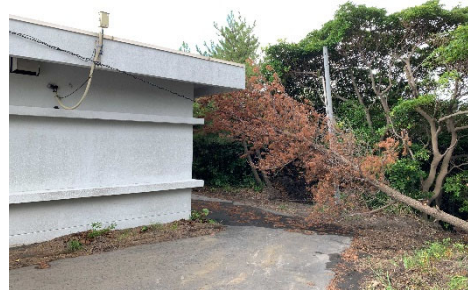
図 3. 光通信ケーブルへの倒木状況
