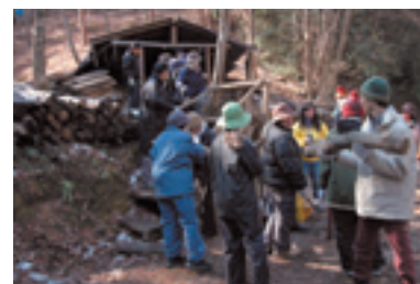
窯への炭材立て込み作業
