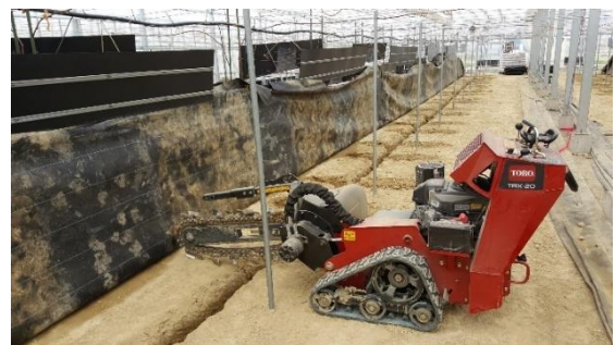
図 1. トレンチャーを用いた掘削風景
