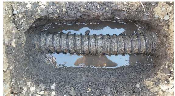
図 2. 露にした既設暗渠管
