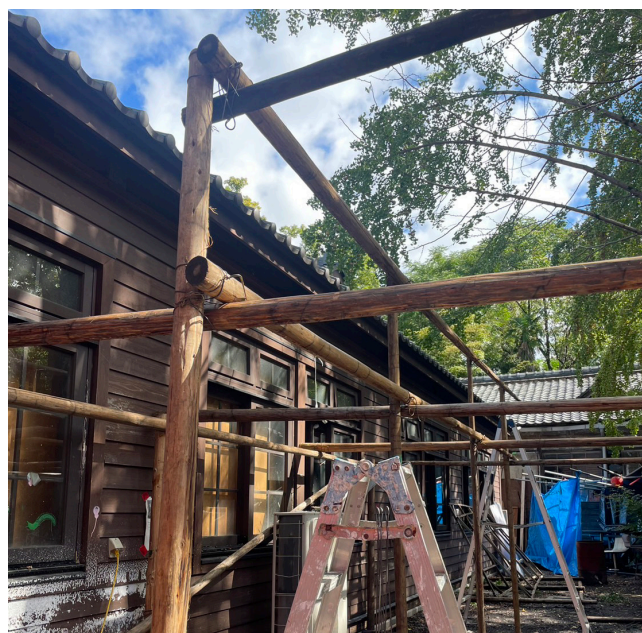
図1 キロンボの建て込み 撮影：traverse25 編集委員
