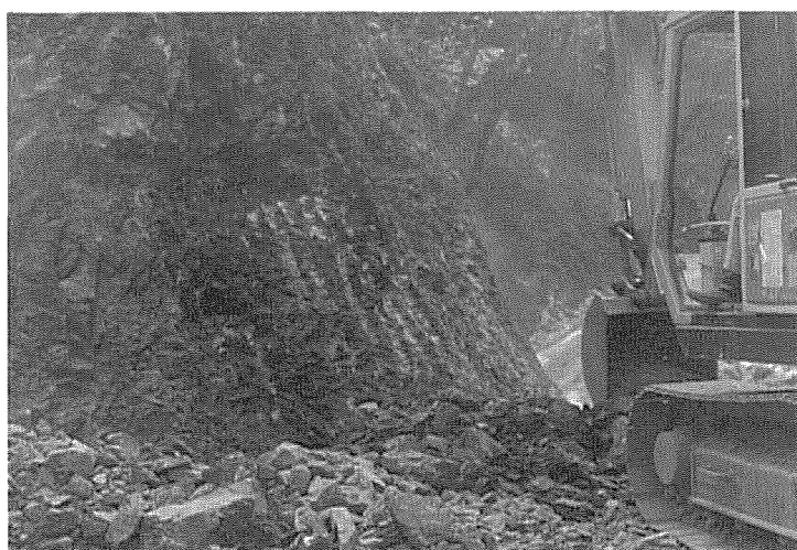
写真3 バックホウによる作業現場
