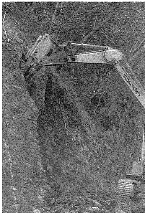
写真2 ブレーカによる作業現場
