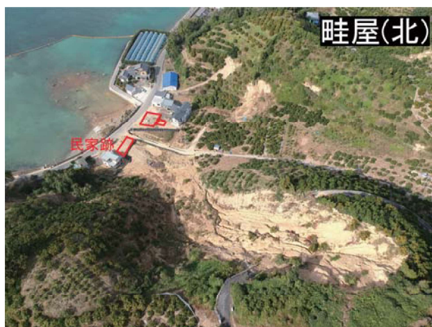
図-5 吉田町畦屋（北）における泥流化した崩壊
